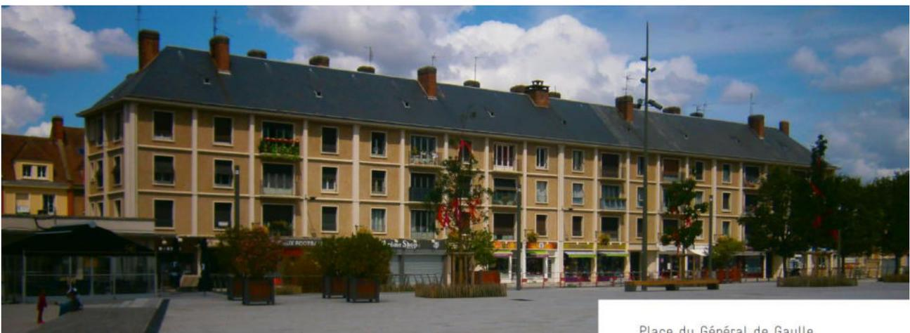
Elle utilise comme matériau de la plastique architecturale la « trame » structurelle de la construction : poteaux, poutres, chaînages des planchers, en la faisant surgir à l'extérieur des parois et en la différenciant des fonds qui apparaissent ainsi comme des remplissages.
